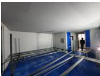
(4) 신규 천장판 설치
