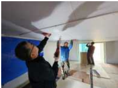
(5) 기존 석고보드 위 덧시공
