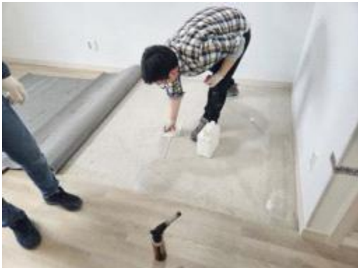
(4) 바닥 표면 확인 후 접착제 도포
