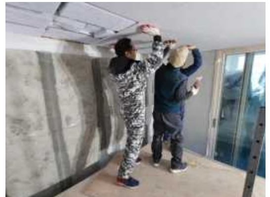
(6) 신규 천장판 설치
