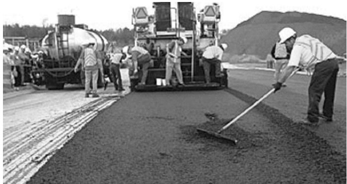
그림1. WMA 포장의 시공 모습
