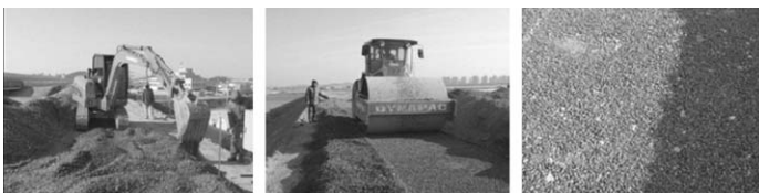
그림3. 페비닐 골재를 도로포장에 활용하는 모습(경기도 김포)
