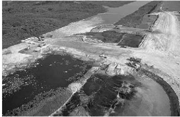
그림5. 검증을 위한 되메우기 공사
