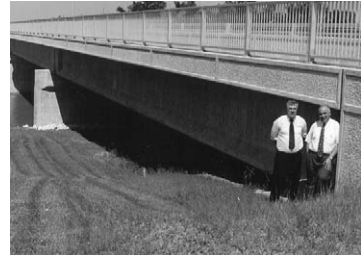
그림2. FRP 긴장재를 이용한 PSC교
