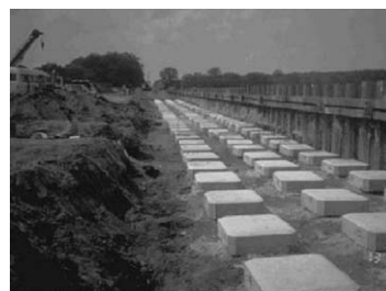
(a) 강관말뚝 시공후 말뚝캡이 설치된 모습
