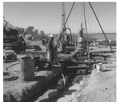
그림3. VRESAP의 파이프라인 공사
