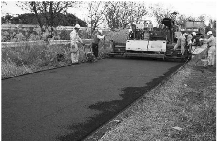
그림6. 2층 동시포설형 아스팔트 피니셔 시험시공 장면 출전 : 독립행정법인)토목연구소 포장팀 홈페이지
