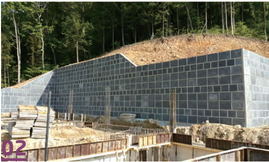
1 고경택 박사와 ㈜제이에이치의 협업을 완성된 콘크리트 옹벽식 패널은 단면 두께를 기존 25cm에서 15cm로 줄여 경제성이 탁월하다. 2 장성산림교육센터에 설치된 ㈜제이에이치의 옹벽식 패널 사례
