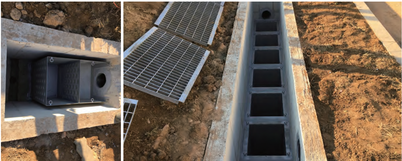
한국건설기술연구원 일산 본원에 시공된 모듈러식 카트리지 도로 비점오염 저감기술
