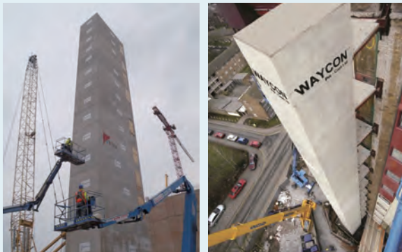
[그림 3] 프리캐스트 콘크리트 모듈러 코어 사례
