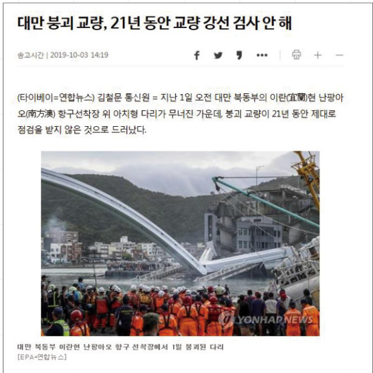
그림 3. 대만 난팡아오 교량 붕괴(2019.10.3.)
