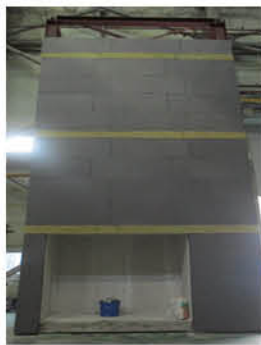
단열재 시공 완료
