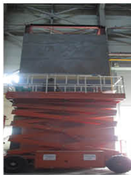
1차 미장 및 매쉬 시공
