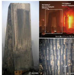
중국 베이징 CCTV 빌딩 화재 사례 (2010)
