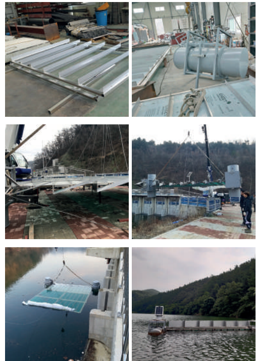
그림 4 수류순환장치 테스트베드 구축 전경
