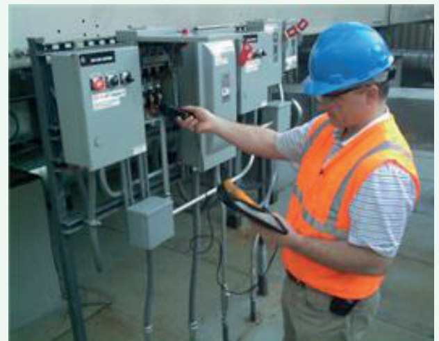
그림 2 레트로커미셔닝 - The Joseph Vance Building Renovation Project
