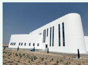
그림 4 APIS COR의 2층 Office 출력물(UAE) 4)
