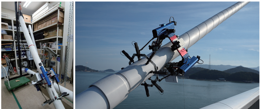
그림 4 케이블 점검 로봇 성능 검증 실험 전경
