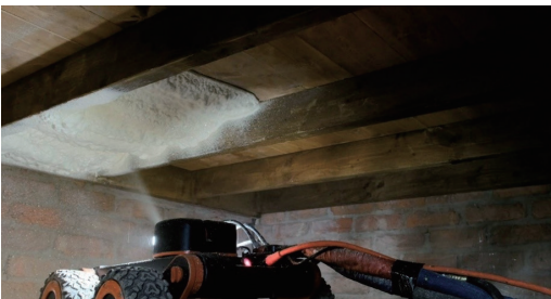
(c) 큐봇의 건설 로봇
