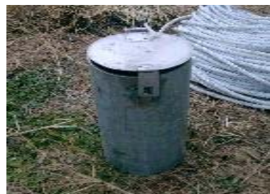
B. 케이싱 상부 자물쇠 설치
