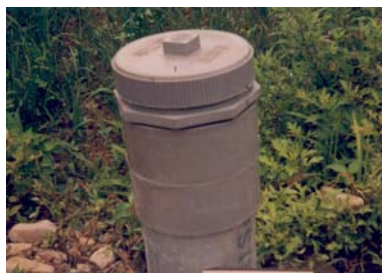
A. 케이싱 상부 덮개 설치
