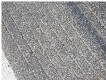
<그림 7.3> 미끄럼방지포장(그루빙) 설치 예
