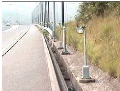
부록-그림 1.4 낮은 조명의 설치 형상(일본)
