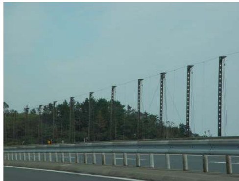
부록-그림 1.1 안개차단망의 설치 형상(작동 전)
