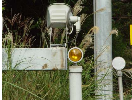
부록-그림 1.5 시선유도등의 설치 형상(일본)
