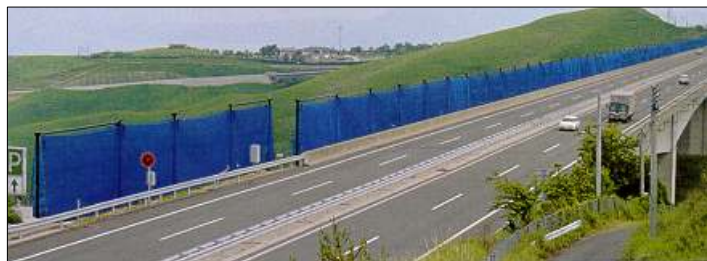
부록-그림 1.2 안개차단망의 설치 형상(작동 중)
