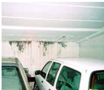
그림 1.3 PC 시스템의 접합부 누수 사례 및 균열 발생 양상
