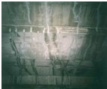
그림 1.2 장경간 RC 시스템의 하부 균열에 의한 누수
