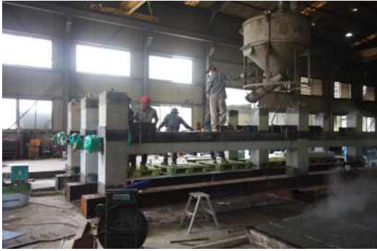
(e) 토평 콘크리트 타설
