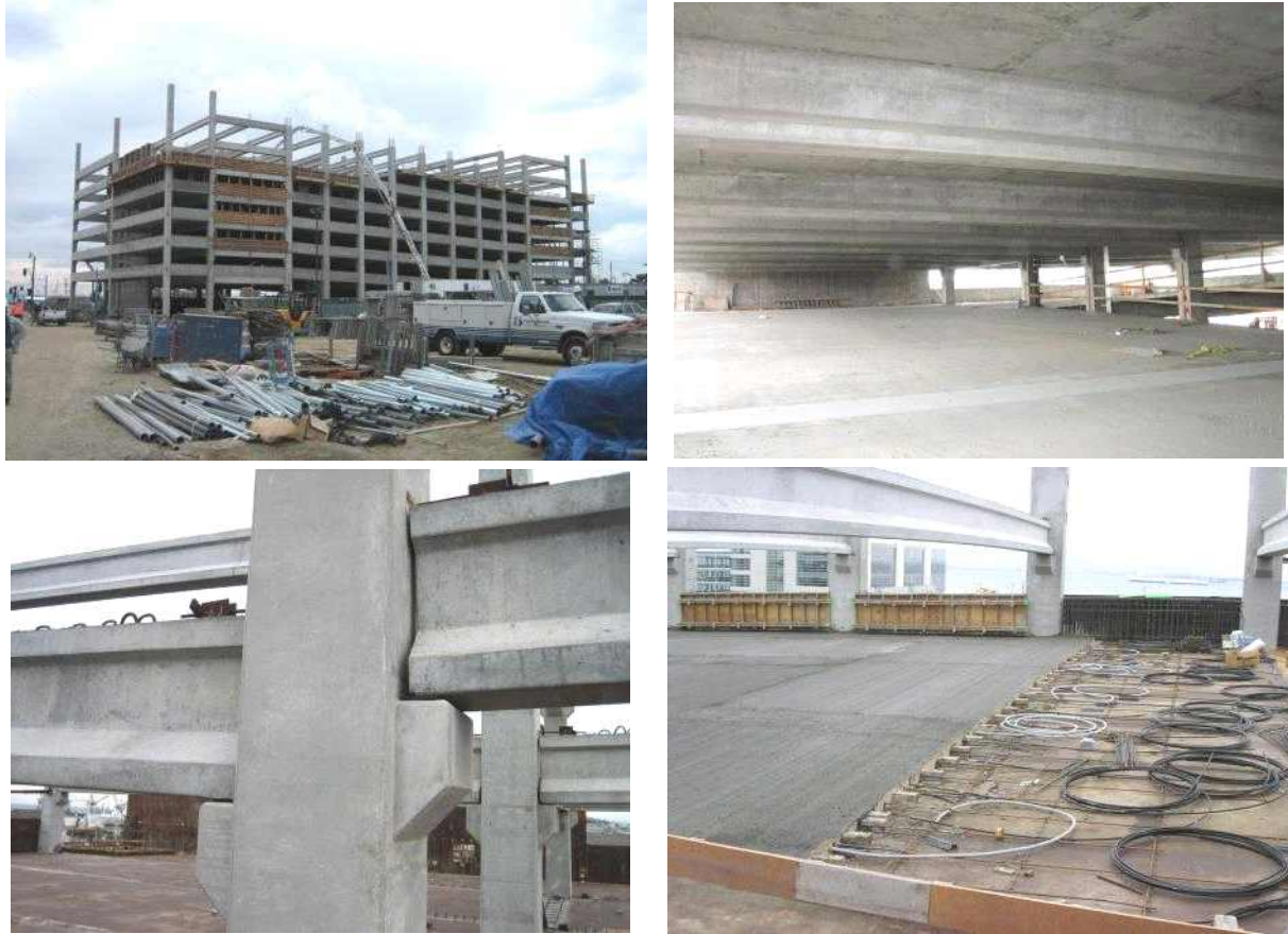
그림 2.2 PC 골조와 PT 슬래브를 혼합한 주차장 건물 시공 사례
