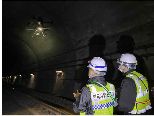
<드론을 활용한 터널 영상취득(국토안전원)>
