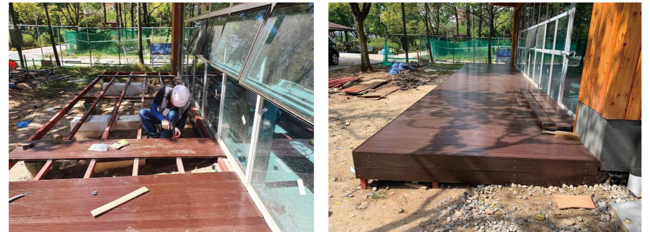
[그림 3.1] CXP 데크 설치 모습(좌), 시공 완료 모습(우)
