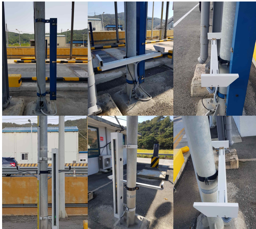
그림3.19 진입 및 진출 속도 수집장치 (포토센서)
