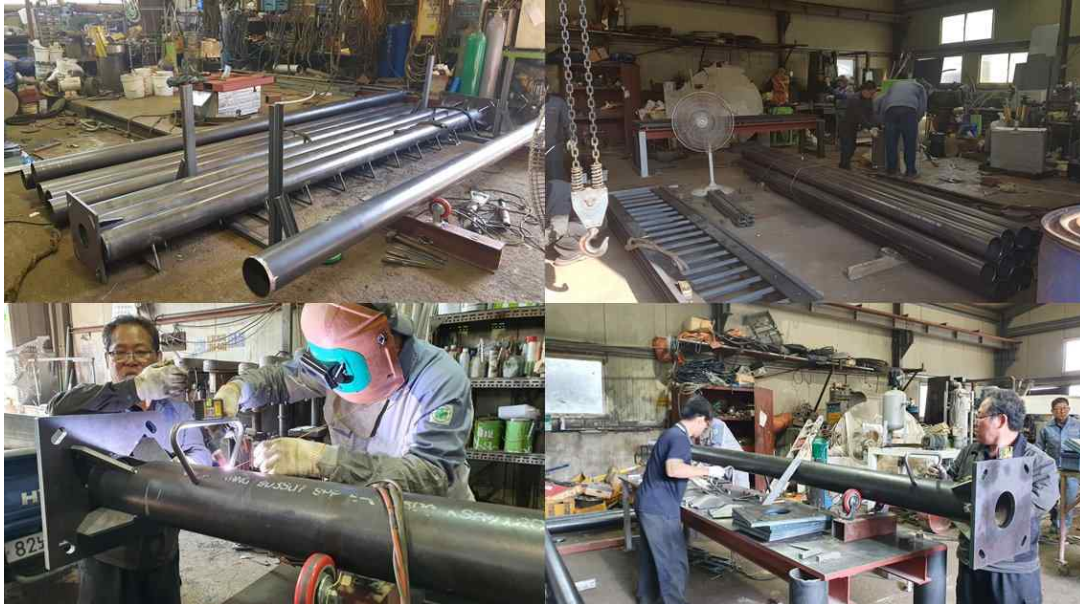
그림3.21 속도측정 기준장치 폴(Pole) 제작
