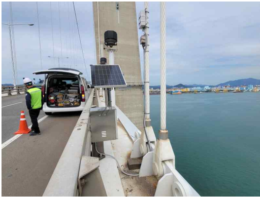
센서 및 솔라시스템 설치완료(CAC05)
