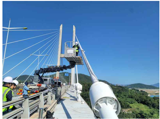
센서 및 솔라시스템 설치완료(CAC06)
