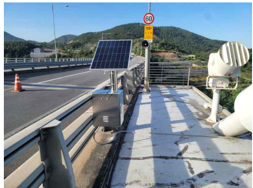
센서 및 솔라시스템 설치완료(CAC06)
