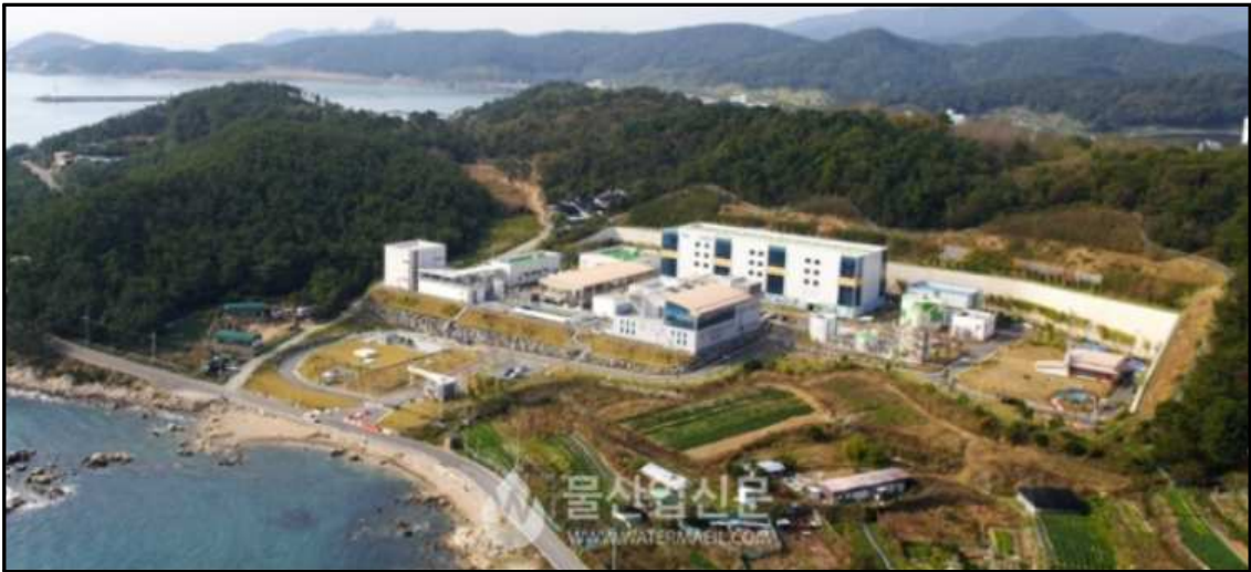
그림 3-1. 부산광역시 기장군에 설치된 해수담수화 시설의 전경
